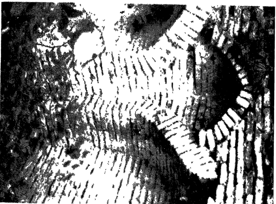
عکس شماره ۸۵ - رویای داخلی بنا را در قلمه رودجان بدین ترتیب برای ردن طاق جمع کرده‌اند
